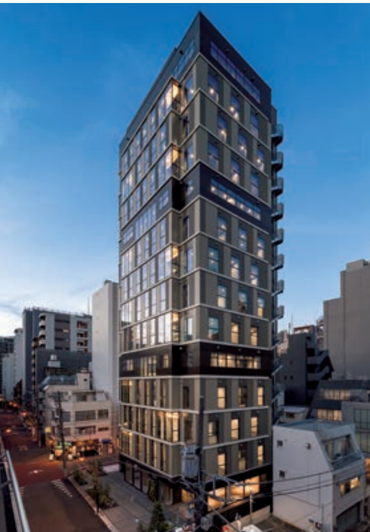
工事名－(仮称)千代田区神田神保町一丁目28計画新築工事 所在地－東京都千代田区
