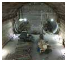
非開削トンネル 内部構築状況
