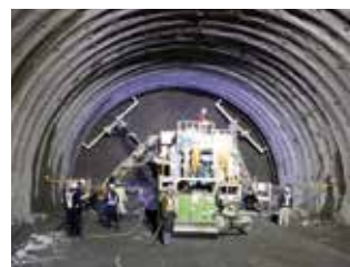
平串トンネル
