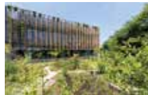
「つくば再生の里」から見た グリーンオフィス棟
