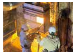
施工状況(山留壁を切断)
