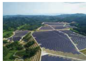
OR山口美祿ソーラー発電所工事
