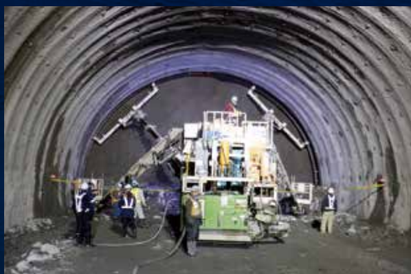
切羽無人化施工システム
