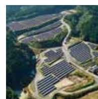
2016年 宮崎国富 メガソーラー発電所
