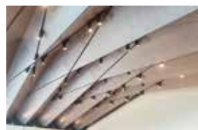
内部の折板天井
