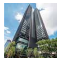
2021年 常盤橋タワー
