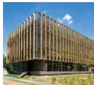
グリーンオフィス棟
