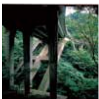
1961年 箱根バイパス天狗橋
