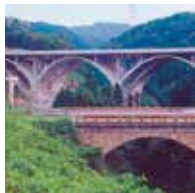
1988年 老ノ坂亀岡バイパス橋
