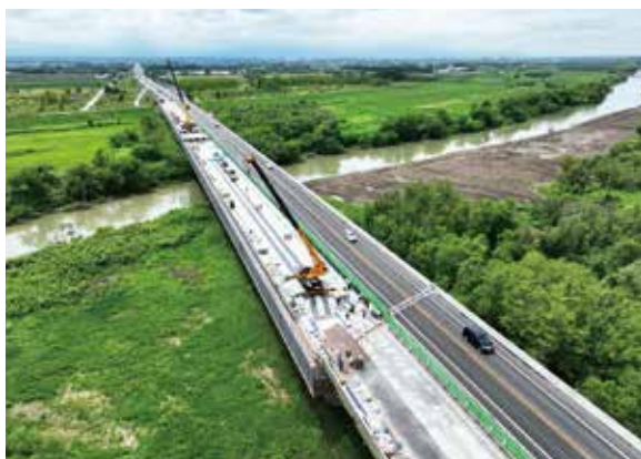
東日本道路 夕張川橋
