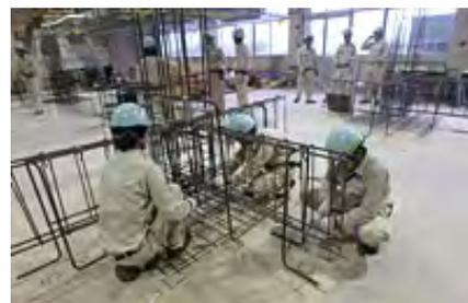
構造鉄筋の組み立て作業の様子
