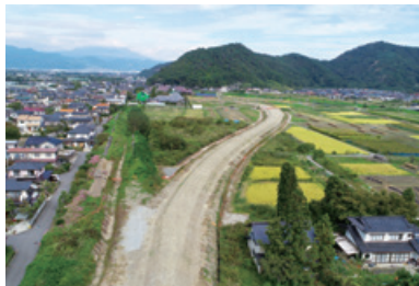
平成29年度 防災・安全交付金（道路）工事
