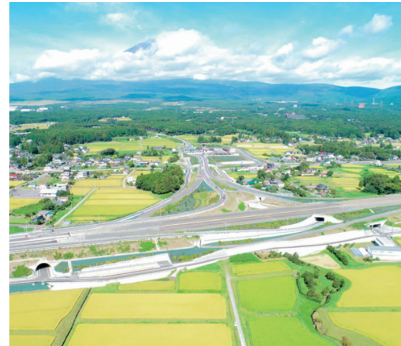
新東名高速道路 御殿場インターチェンジ工事 静岡県駿東郡小山町～静岡県御殿場市 発注者: 中日本高速道路株式会社
