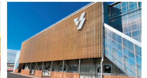
▲天然木ルーバー
