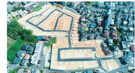
遠鐘プロジェクト 宅地造成工事 愛知県東海市 発注者: 日鉄興和不動産株式会社
