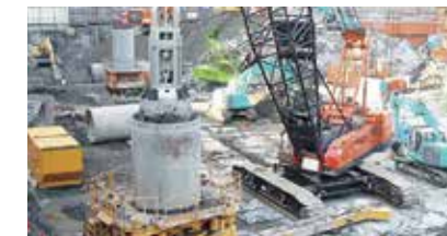
新丸の内ビルディング工事
