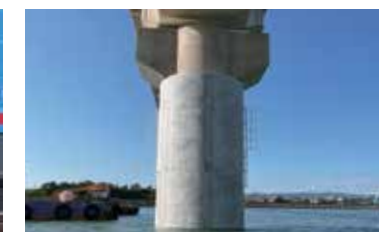
コンファインド工法による紀ノ川河口大橋の橋脚補強工事
