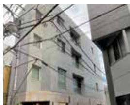
経堂ビル新築工事
