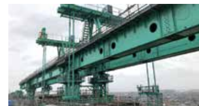
城陽第二高架橋西・東向け架設機
