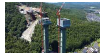
信楽川橋(PC上部工)工事
