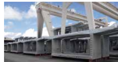
橋梁セグメント
