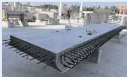
スチームレスプレキャストコンクリートで製造したPCaPC床版
