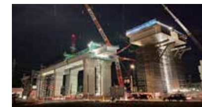
城陽第二高架橋東(PC上部工)工事
