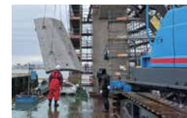
コンファインド工法による紀ノ川河口大橋の橋脚補強工事
