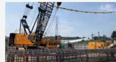
LRT案件工事～中央分離帯での作業～
