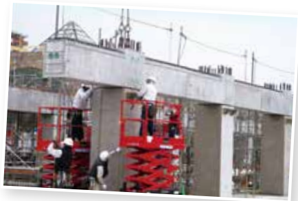
ピー・エス・コンクリート社で製作した部材をピーエス三菱の建築施工現場にて架設・接合
