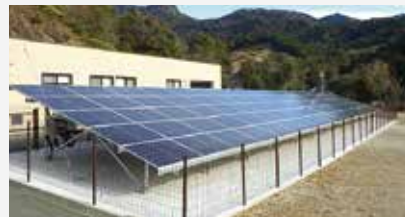
太陽光発電パネルの設置
