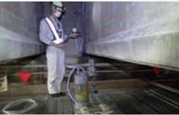
内阿原避溢橋(リパッシブ工法)注入状況
