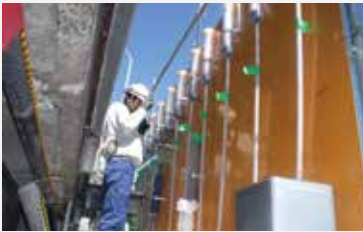
内阿原避溢橋(リパッシブ工法)注入状況
