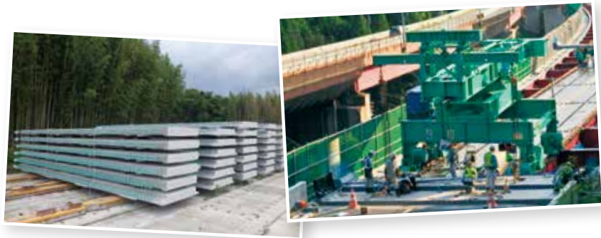
ピー・エス・コンクリート社で製作したPC床版(写真左)をピーエスケー社の機材「橋上架設機」を使用し架設する橋梁工事現場
