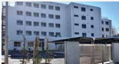
江戸川台寮改修工事
