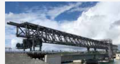
泡瀬橋梁バランスドカンチレバー架設機
