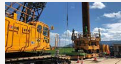
東海環状4車線化工事
