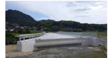
橋梁新設工事(新本川橋(仮称)上部工)
