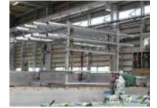
外ケーブル工法用の偏向管と架台
