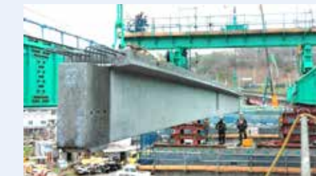
下庄跨線橋(岡山県)に採用されたSLPC桁
