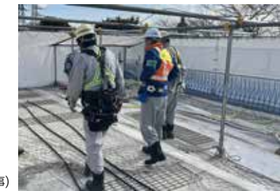
社長・年頭パトロール(圏央道吉原高架橋工事)
