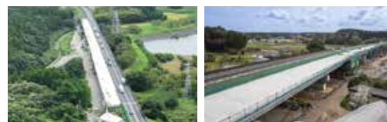
吉原高架橋工事(茨城県土浦市) 古和高架橋工事(千葉県山武市)
