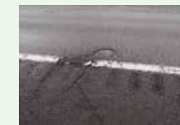
ポットホールと路面のひび割れ
