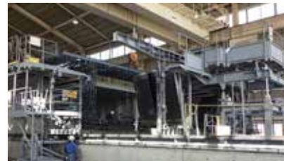
城陽第二高架橋西・東ロングライン方式鋼製型枠
