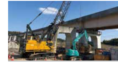
圏央道増杭工事
