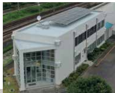
屋上に設置可能な最大範囲で太陽光パネルを設置
