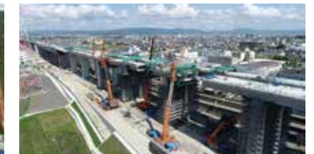
城陽第二高架橋東工事
