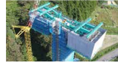
橋梁施工のための移動作業車
