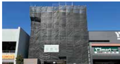
某ビル大規模修繕工事
