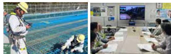
音声入力システム(吉原高架橋) 360°画像共有システム(吉原高架橋)
