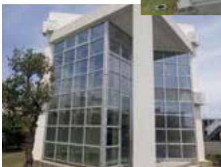
エントランスカーテンウォールのガラスを断熱遮熱性能の高い真空ガラスに更新
