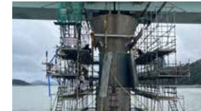
コンファインド工法による川内河口大橋耐震補強(P3)工事
