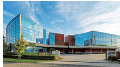
本建物は、隣接する本社棟デザインの特徴である曲線のモチーフを取り入れ、高さや外壁面を揃えることで既存棟との一体的な景観を形成しています。カーテンウォールを採用することにより、美濃の山々を望むパノラママウンテンビューを提供しています。また、本工事の取り組みにあたってはBIMを活用し、着工前から建物外観や建物内部の完成イメージを共有しながら工事を進めました。
