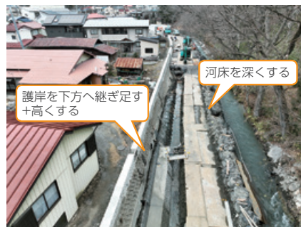
流域面積を拡張する工事の様子
