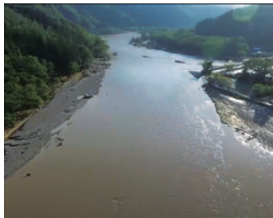
小本川被災状況
