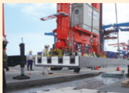
試験施工の様子
