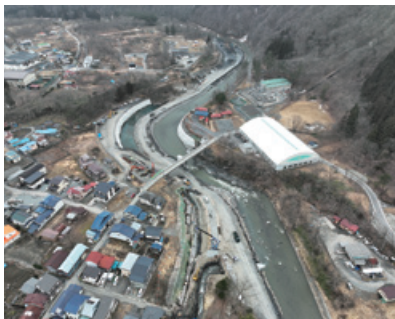
約3.5kmにわたり河川を改修
