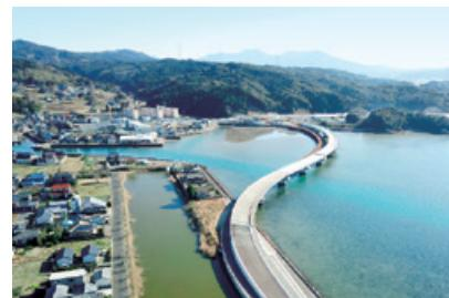
本工事は、佐賀県伊万里市に位置し国道204号と国際コンテナターミナル等を結び臨港道路の橋梁区間（全橋長431m）のうち、120.5mのPC3径間連結T桁橋の上部工工事です。
