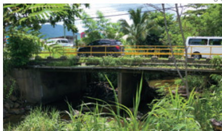
カルデサック流域橋梁現橋の様子
