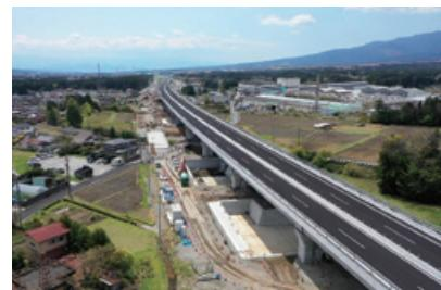
本工事は、新東名高速道路の新御殿場IC—御殿場JCT間7.1kmのうち、1.5kmをPC上部工（一部鋼橋）で施工しました。同時期に開通する国道138号バイパスと接続されることで、富士山周辺、箱根、伊豆方面への観光促進による地域活性化が期待されています。
