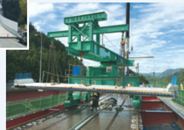
大規模更新事業(床版取替)
