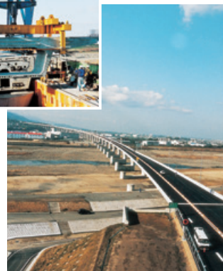
1997年 高速道路整備(スパンバイスパン工法)
