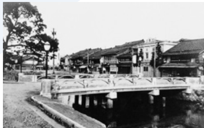
1952年 日本初のPC橋(長生橋)
