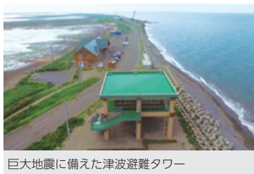
巨大地震に備えた津波避難タワー
