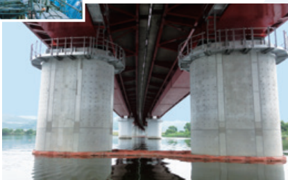
橋梁耐震補強(コンファインド工法)
