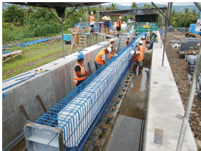
簡易設備での桁製作の様子
