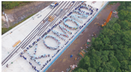
菰野第二高架橋（三重県）
