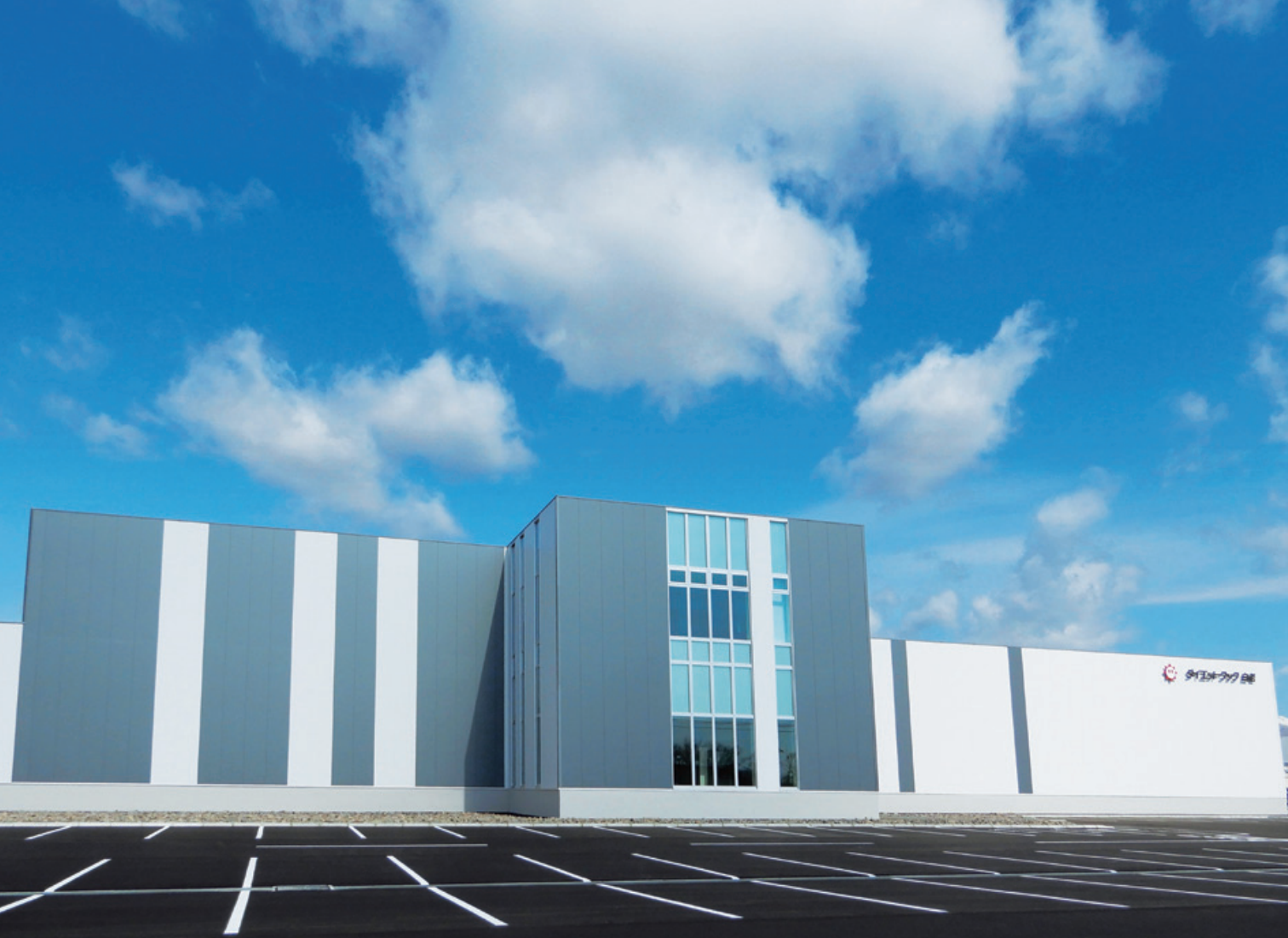
ダイエツクック白老新工場建設工事（北海道）
