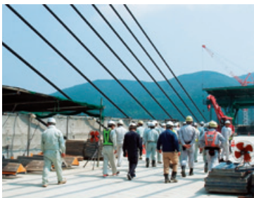
長崎自動車道日見夢大橋（長崎県）
