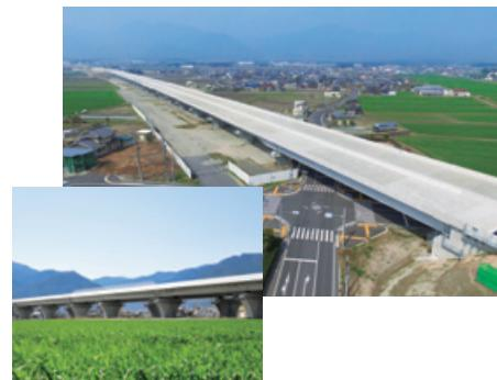
本橋は、新名神高速道路新四日市JCTの西部に位置する上り線751m、下り線708mの鋼-コンクリート複合構造の橋梁です。将来的には片側3車線を見据えた構造であり、今回は暫定形（片側2車線）での開通となっております。
