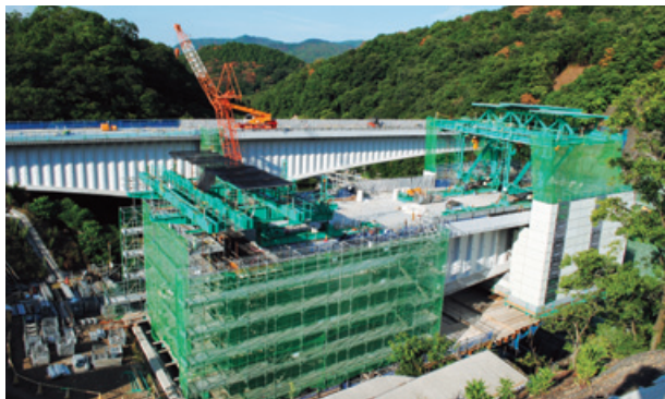
張り出し架設の様子
