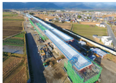
池底高架橋 (PC上部工) 工事
