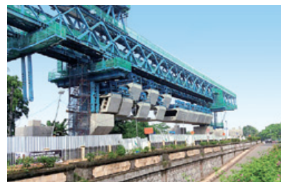
セグメントボックス桁製造（インドネシア）
