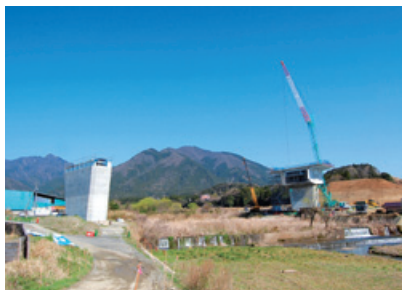
内部川橋他3橋 (PC上部工) 工事
