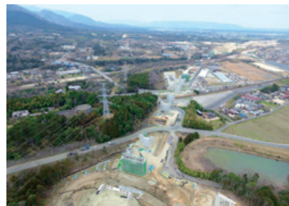
菰野第二高架橋他3橋 (PC上部工) 工事
