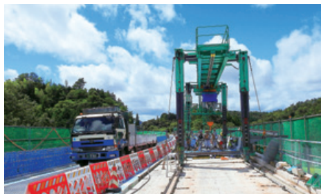
半断面床版取替工事の様子
