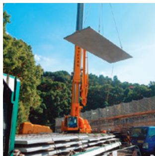
直島独身寮に使用しているPCa床版
