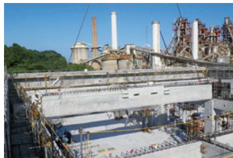
現在施工中の九州工場
