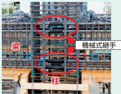
機械式継手を使った鉄筋の接合
