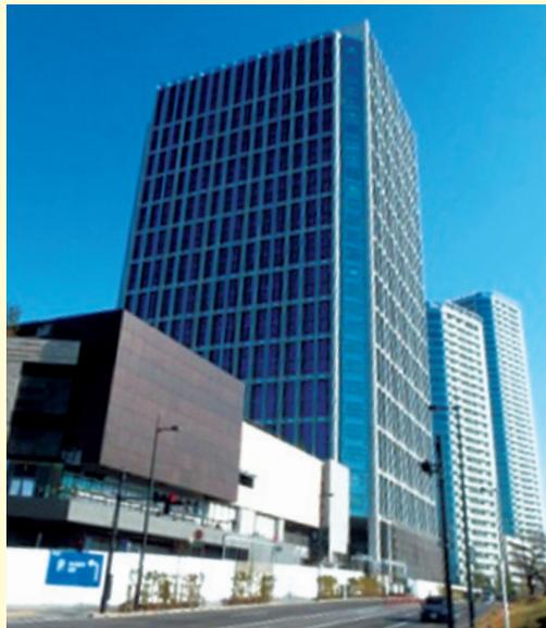
本建物は、店舗・事務所・ホテル等を主要な用途とした複合施設です。地下2階、地上30階、延べ床面積146,422㎡、最高高さ137.0mであり、RC造一部S造の免震構造が採用されています。部材をPCa化することで省力化、工期短縮を実現しました。
