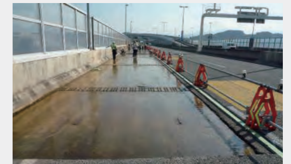
アスファルト代替材料 高性能防水工法(タフシャットRA)
