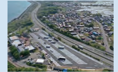
北陸自動車道(特定更新等)金沢管内 舗装補修工事(2020年度) 特定建設工事共同企業体(石川県)
