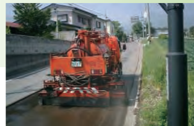
アスファルト乳剤散布状況
