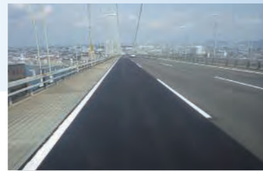
本州四国連絡高速道路(株) 令和4年度神戸管内舗装補修工事(兵庫県)
