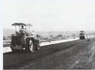
1962年 日本初の高速道路建設・ 名神高速道路
