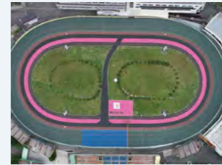
2018年 防府競輪場走路改修工事
