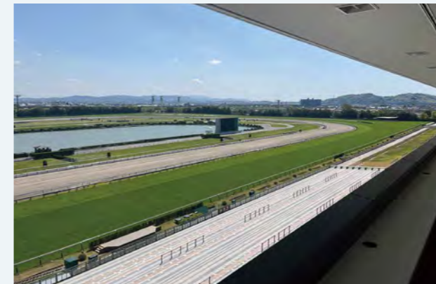
清水建設との共同企業体(JV)による京都競馬場整備工事(馬場工区)
