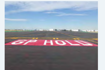
2019年 東京国際空港B滑走路取付 誘導路他舗装等工事
