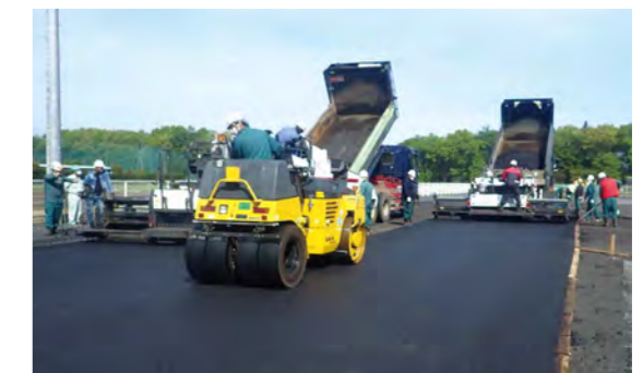
施主様にはローラ・切削機で日頃より大変お世話になっています
