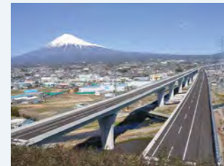
2011年 新東名高速道路富士東舗装工事
