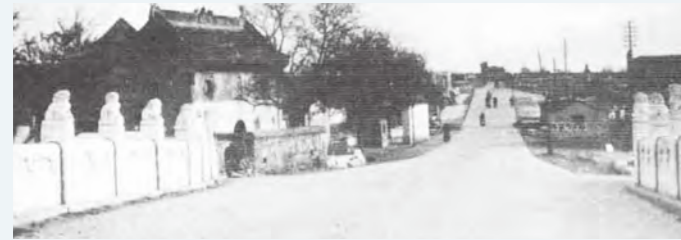
1939年 北京市盧溝橋舗装工事
