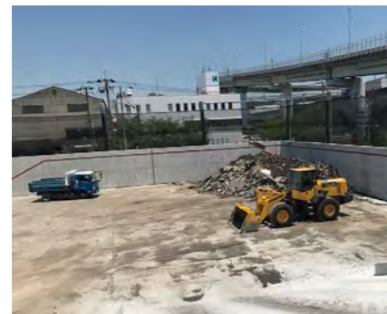
廃材受け入れヤード
