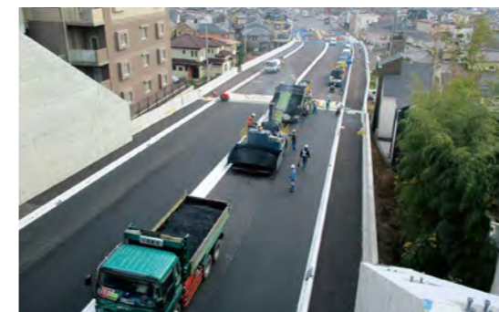
埼玉県内初の2層式低騒音舗装を施工しました
