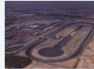
1993年 マレーシア・プロトン社 テストコース他新設工事
