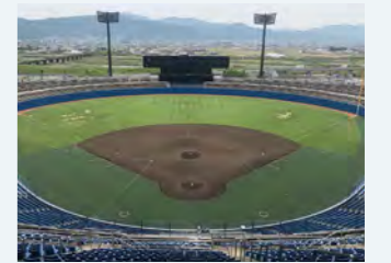
2022年 坊ちゃんスタジアム内野 グラウンド改修工事
