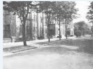
1939年 東京帝国大学構内舗装工事
