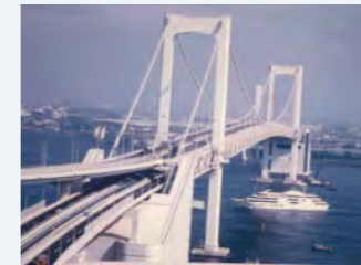
1993年 東京湾連絡橋(レインボーブリッジ) 芝浦地区橋面舗装工事
