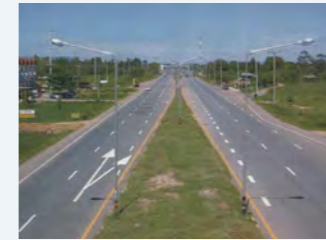
2002年 タイ・国道12号線コンケン〜 ノンルア間改良工事
