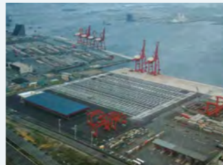
1974年 大井ふ頭第3バースヤード工事
