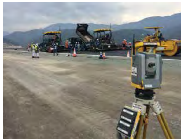
トータルステーションによるマシンコントロール
