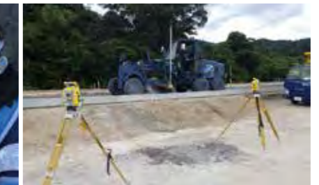
③重機稼働域での作業軽減および安全性の向上
