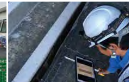
②図面と現地照査
