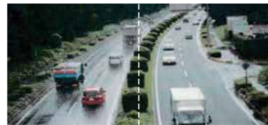
通常舗装 排水性舗装
