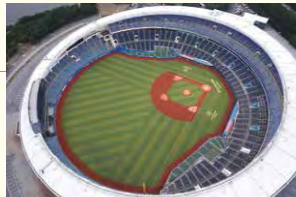
ZOZO マリンスタジアム人工芝工事 (千葉市)
