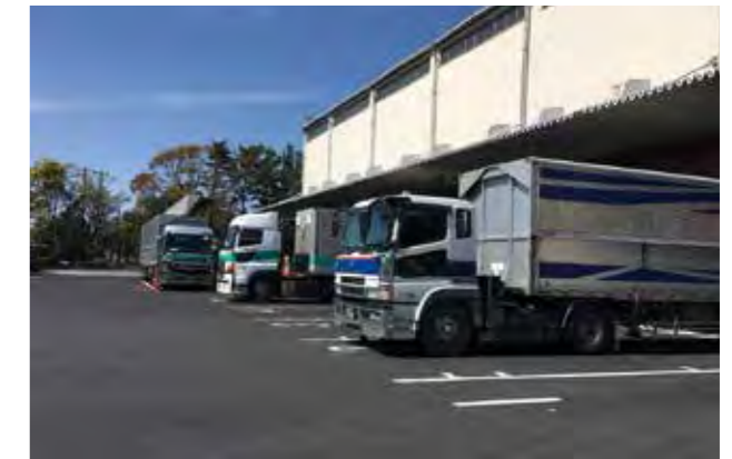
花王株式会社 和歌山工場トラックヤードの施工例
