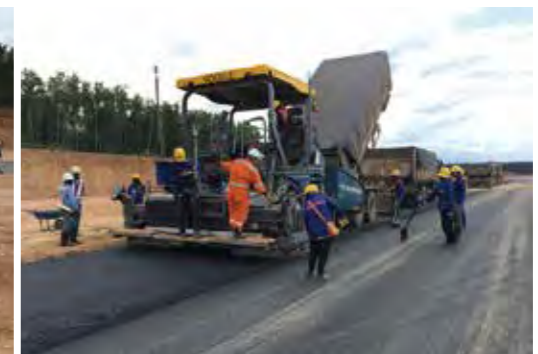
TS（トータルステーション）を用いた、タイでは業界初となるAFナビを使用した情報化施工を導入
