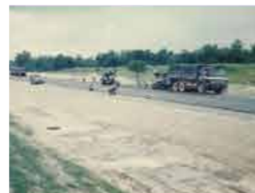
バンコク-チョンブリ高速道路工事 (1994年)
