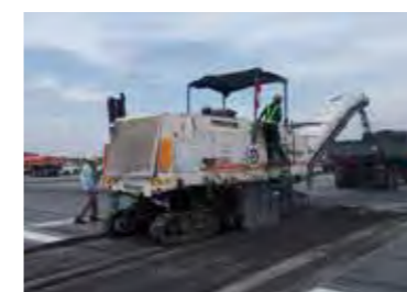
滑走路の凹凸箇所を 切削機で除去
