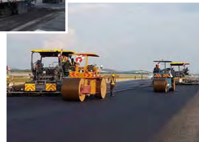
大型アスファルトフィニッシャー 2機を投入し、2,000t/日を施工
