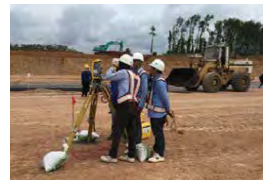
現地スタッフに対し、施工体制のスキルアップを目的に情報化施工の研修も実施
