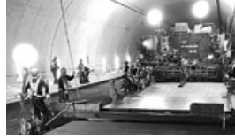
▲トンネル舗装工事（情報化施工）
