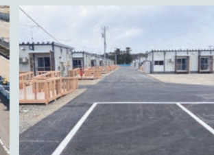
珠洲市多目的広場応急仮設住宅建設工事
