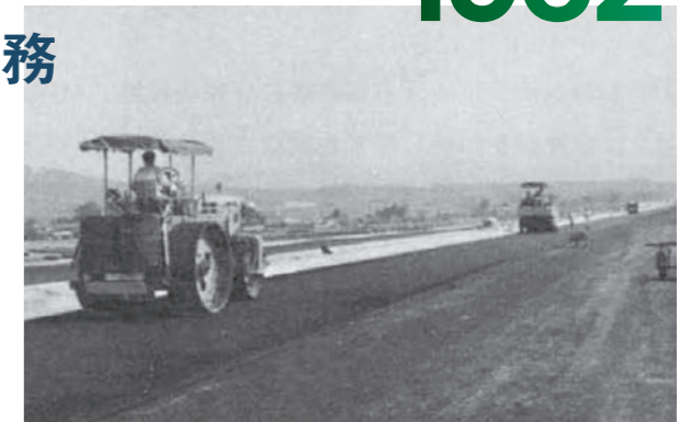
名神高速道路 吹田・茨木舗装工事
