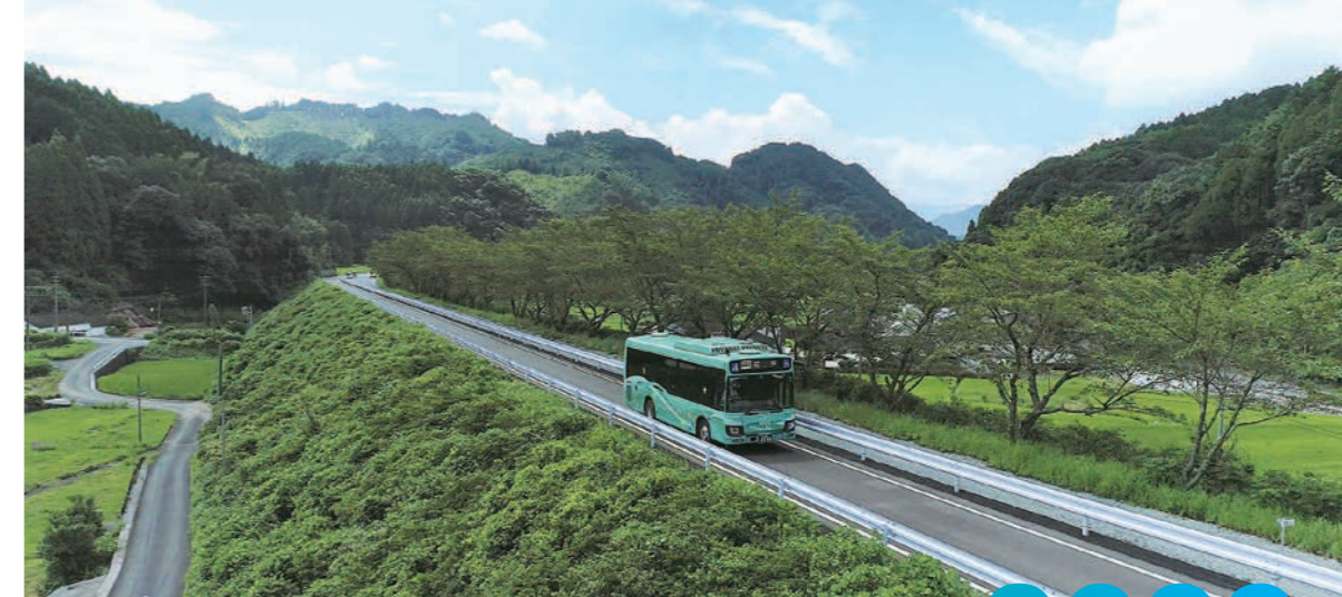
「PETアスコン」を施工したBRT専用道
