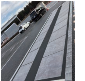
太陽光発電舗装
