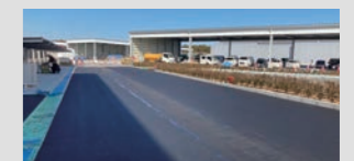
「バイオ炭アスコン」施工事例(土浦テクノBASE内)
