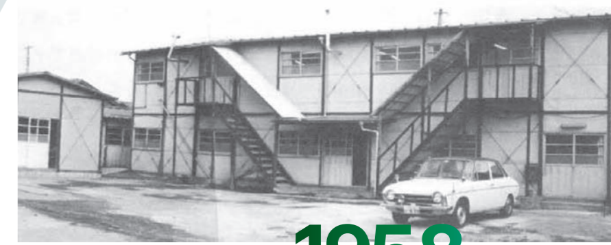
技術研究所の建物全景
