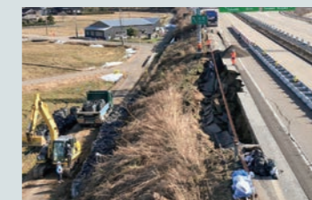
北陸自動車道小矢部IC～小矢部砺波JCTの復旧工事
