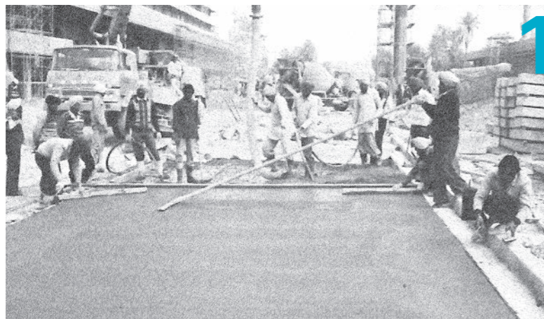
マレーシアでの施工風景
