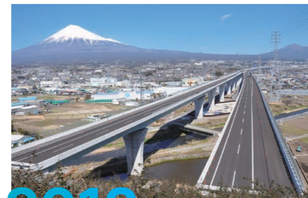
新東名高速道路 富士東舗装工事
