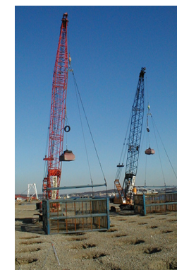
動圧密工法の工事の様相
