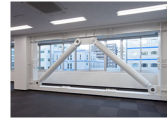
耐震補強工事
