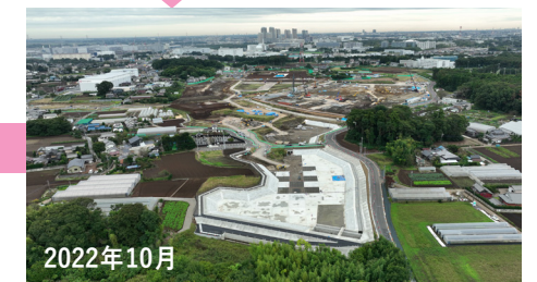
2022年10月 構造物の建設
