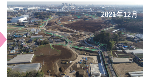
2021年12月 土地の造成・改良工事
