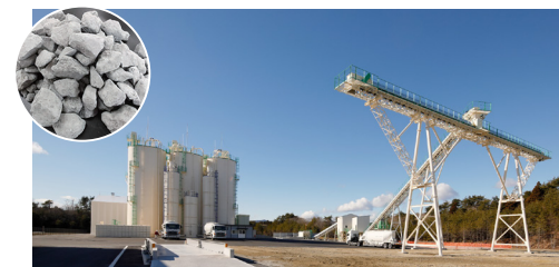
人工砕石製造プラント (左上は石炭灰リサイクル砕石)
