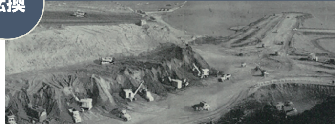
1957年：日本初のリッパ工法を確立（横須賀火力発電所造成工事）
