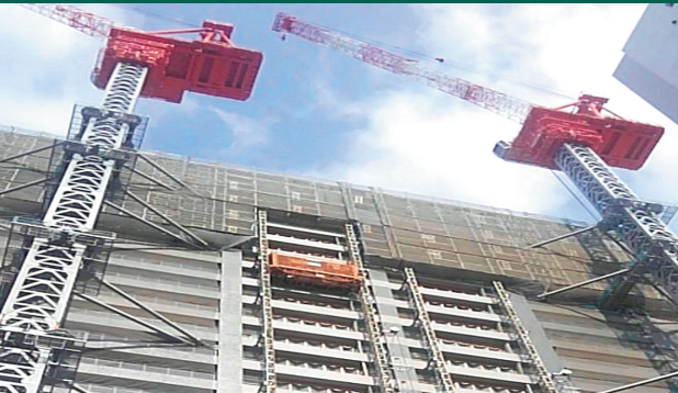
プレキャストコンクリート工法（PCa工法）による施工の模様
