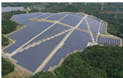
松島どんぐり太陽光発電所（発電出力 50MW）
