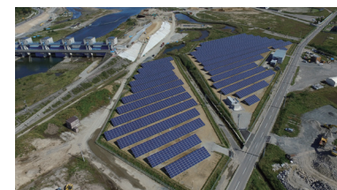
津軽石太陽光発電所 発電能力 1,607kw パネル 6,300枚
