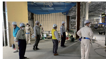
建設現場での安全パトロールの様様
