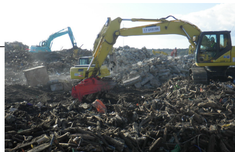
南相馬市でのがれき処理作業の様子
