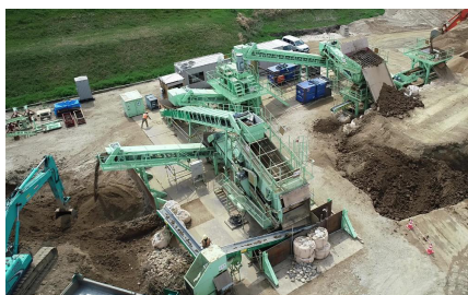
回転式破碎混合工法（ツイスター）
