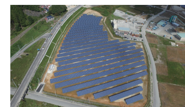
田老太陽光発電所 発電能力 2,367kw パネル 9,282枚
