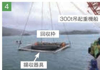
軽石を集積した回収器具を揚収器具を用いて吊り上げ、
