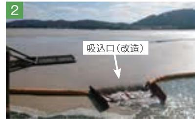
2 船外機と汚濁防止膜で軽石を吸込口に誘導し、吸込口の高さを調整しながら、
