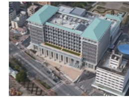
呉市新庁舎竣工(2015)
