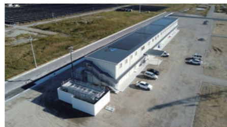
ZEB認証を取得した 工事事務所
