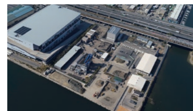
市川土壌再利用センター
