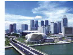
シンガポール、エスプラネードシアターズオンザベイ竣工(2002)
