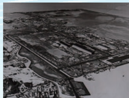
日本鋼管福山臨海工業用地造成工事受注(1961)
