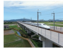
九州新幹線玉名津留高架橋完成(2008)
