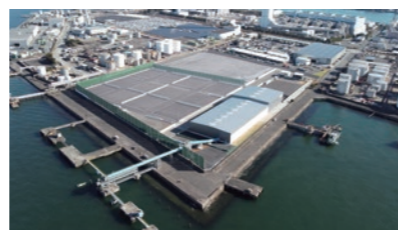
名古屋土壌再利用センター
