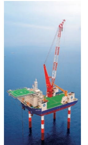
SEP型多目的起重機船「CP-8001」完成(2018)
