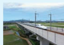
九州新幹線玉名津留高架橋完成(2008)
