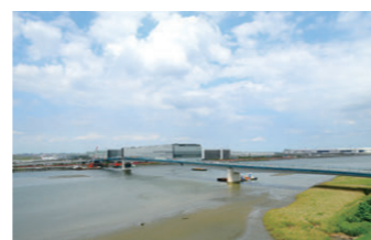
橋梁設置・干潟表土復元後の状況
