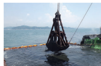
浅場・干潟造成状況(カルシア改質土の投入)
