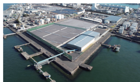
名古屋土壌再利用センター
