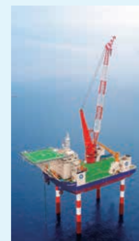
SEP型多目的起重機船「CP-8001」完成(2018)
