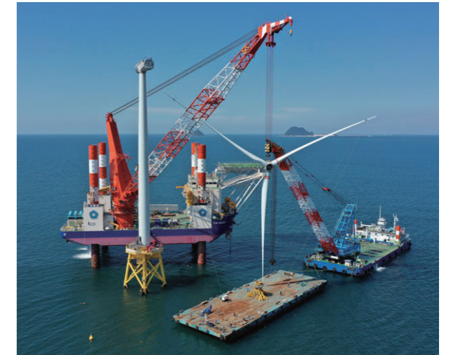
北九州沖洋上風力撤去(風車奥の船舶がCP-8001)
