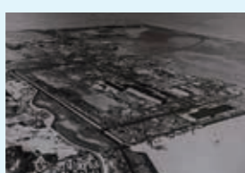
日本鋼管福山臨海工業用地造成工事受注(1961)
