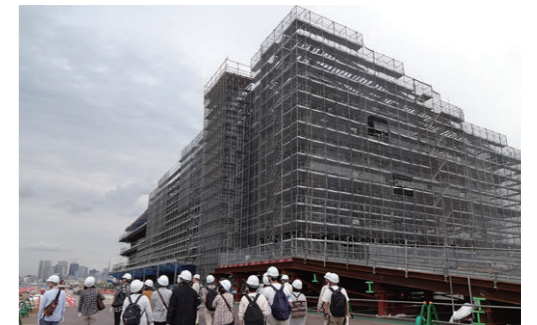
個人株主様向け現場見学会(2019年9月) 13号地客船ターミナル新築工事
