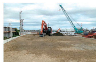
干潟表土の仮置き状況
