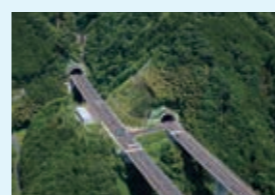
新東名高速道路小河内トンネル完成(2005)
