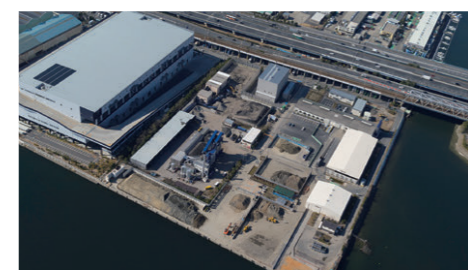
市川土壌再利用センター
