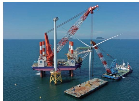
北九州沖の実証機撤去工事
