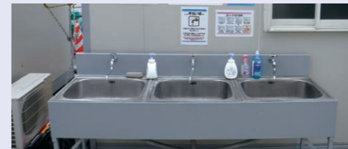
手洗い場等に消毒液を設置
