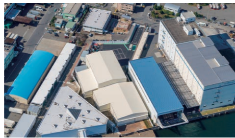
横浜土壌再利用センター
