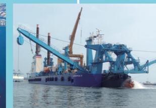
自航式ポンプ浚渫船 「カシオペア V」が完成 (2014)
