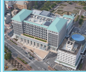
呉市新庁舎が竣工 (2015)
