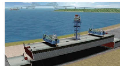
「キーエレメント工法」による沈埋函据付
