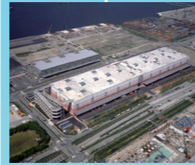
ワールド流通センターが 竣工 (1993)
