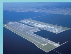
関西国際空港 1期空港島を受注 (1986)
