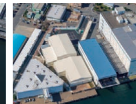
横浜土壌再利用センター
