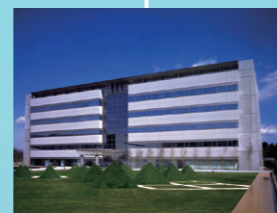
栃木県那須塩原市に 技術研究所が完成 (1994)
