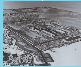
日本鋼管福山臨海 工業用地造成工事を受注 (1961)
