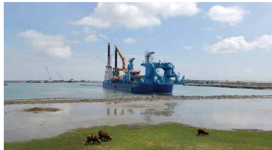
本工事で浚渫するカンオペアV
