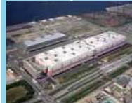
ワールド流通センターが 竣工 (1993)
