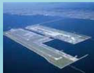
関西国際空港 1期空港島を受注 (1986)
