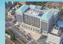
呉市新庁舎が竣工 (2015)
