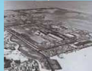
日本鋼管福山臨海 工業用地造成工事を受注 (1961)
