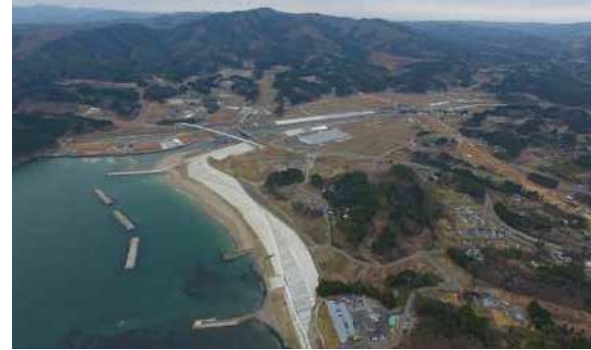
工事の進捗状況(2018年5月現在)
