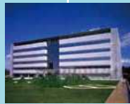
栃木県那須塩原市に 技術研究所が完成 (1994)
