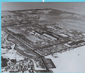
日本鋼管福山臨海 工業用地造成工事を受注 (1961)
