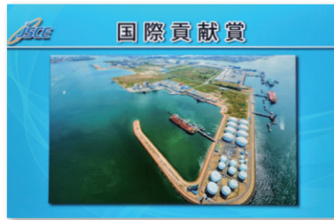
ジュロン第4期チュアス埋立工事(シンガポール)
