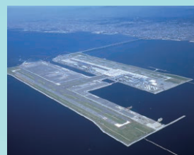
関西国際空港 1期空港島を受注 (1986)
