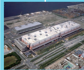
ワールド流通センターが 竣工 (1993)
