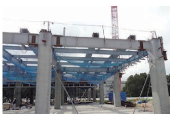
設計・施工案件への 柱プレキャスト・梁鉄骨構工法の採用
