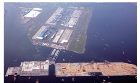
東京国際空港D滑走路(施工当時)
