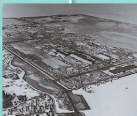
日本鋼管福山臨海 工業用地造成工事を受注 (1961) 東京証券取引所 第二部に株式上場 (1962) 東京証券取引所 第一部に昇格 (1964)
