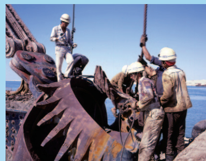
カッターヘッドの交換作業
