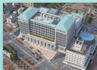
呉市新庁舎が完成 (2015)
