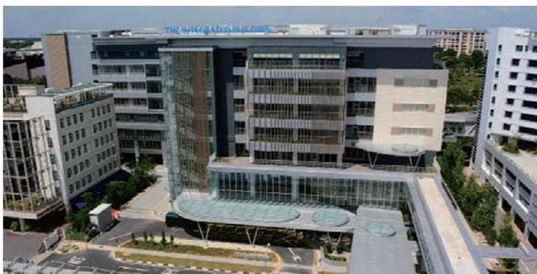
当病院は、シンガポール政府が進める医療政策「Healthcare 2020」の中で“シンガポール東部地域医療の中核”となる医療施設です。短工期で完成させるために逆打工法を採用し、地下躯体と地上躯体工事の同時進行で施工しました。設計調整には、BIM(p.5参照)を導入し、手戻りを最小限に抑え、品質を確保するとともに、安全および近隣への影響も十分配慮しながら施工をしました。
