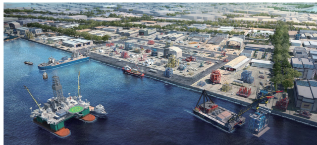
オフショアマリンセンター2 （岸壁エリア及び作業ヤード・管理事務所棟建設工事） （出典：Aurecon GroupのWebサイトより）
