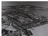
日本鋼管福山臨海工業 用地造成工事受注 （1961）
