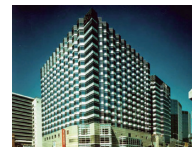
サンプラザビル受注 香港へ進出（1986）
