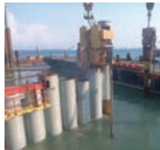
鋼管矢板の打設状況
