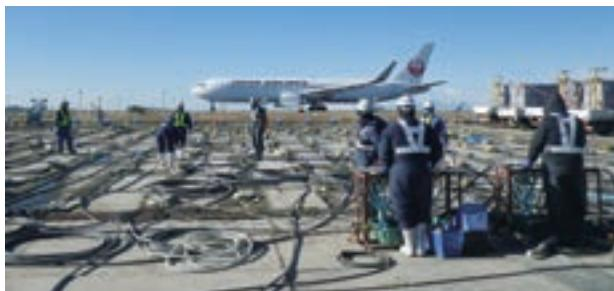
飛行機が離着陸する中での施工（薬液注入状況）
