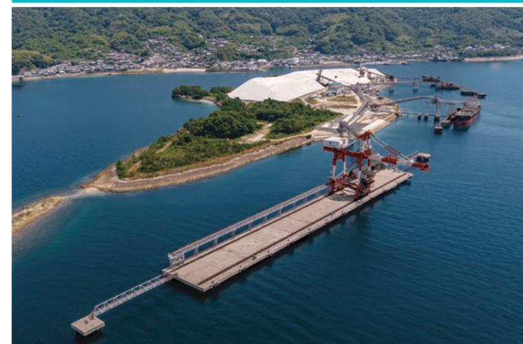
当工事は、国内最大の原塩ターミナルである三ツ子島埠頭において、既存施設を供用しながら大規模棧橋(水深18m、延長240m)を建設する工事です。棧橋上部工を前例のない大型プレキャスト部材(1,600t/基×12基)で架設することにより、棧橋施工の急速化と経済性を両立しました。当棧橋構築技術は「令和5年度土木学会賞 技術賞」および「日建連表彰2024 第5回土木賞」を受賞しました。
