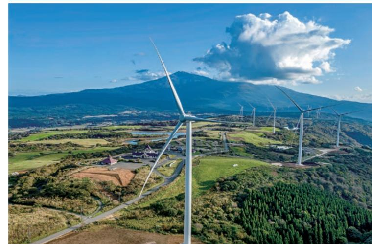
当工事は、2001年に運転開始した仁賀保高原風力発電所の15基の風車(出力1,650kW)を、陸上風力発電では国内最大級の風車(出力4,300kW)6基に建て替える工事です。全長約60mのブレード輸送では牽引式起立式台車(FTV)を使用する等の様々な工夫を取り入れ、秋田港から現地までの78kmにおよぶ距離を移動させました。
