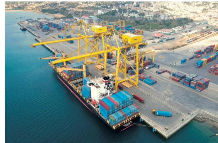
当工事は、モザンビーク政府発注の有償円借款プロジェクトで、既存のナカラ港を増深、埋立により拡張し、コンテナ船専用ふ頭を含む既設港湾施設を再整備する工事です。
