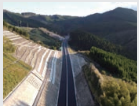
東九州道(清武～北郷)赤木地区外舗装工事
