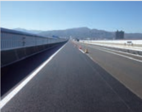
札幌自動車道発寒高架橋床版防水工事
