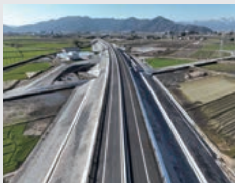
大野油坂道路田野地区他舗装他工事
