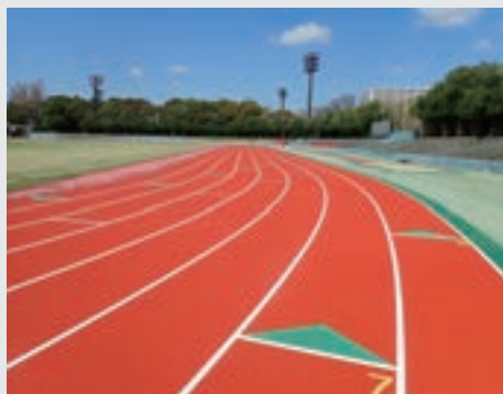
記念公園陸上競技場改修工事
