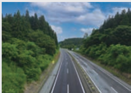
東北自動車道十和田管内舗装補修工事
