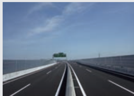
名古屋第二環状自動車道名古屋西JCT～飛島JCT間舗装工事
