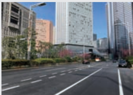
副10号高架橋長寿命化工事(その1)
