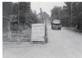
会社設立当時の舗装工事
