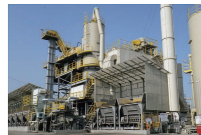
② アスファルト合材工場
