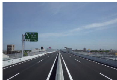
① アスファルト舗装工事
