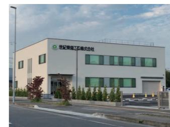
東葛営業所 (ZEB (*) の分類：ZEB Ready)
