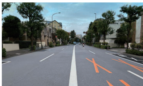
① 東京都 ② 路面補修工事(4二の9・遮熱性舗装) ③ 東京都
