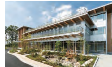
筑波研究所 新研究棟
