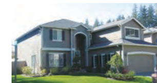
シアトル分譲住宅
