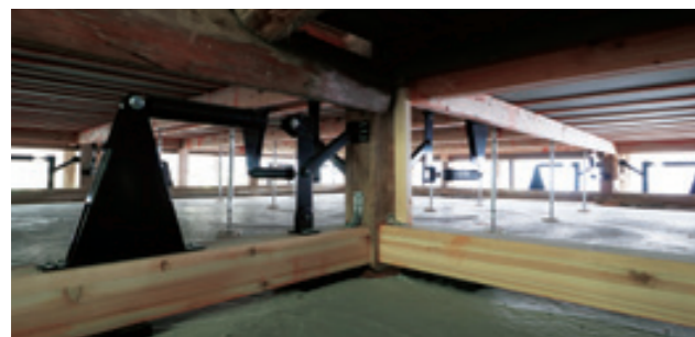
建物の揺れ幅を低減させる当社グループオリジナルのエネルギー吸収ダンパー
