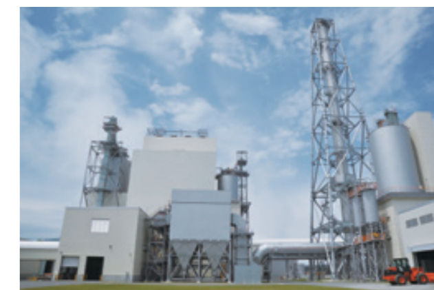
紋別バイオマス発電所
