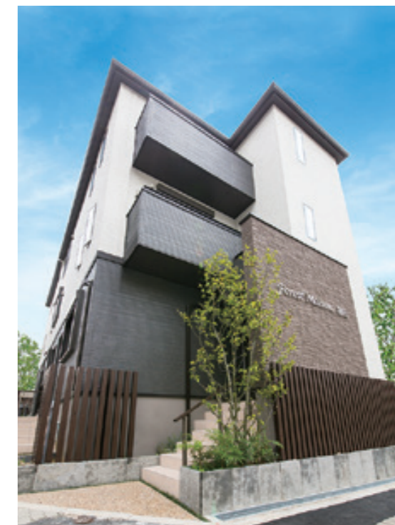
賃貸住宅「フォレストメゾン」外観
