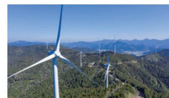
約8,000世帯分の電力を発電する「DREAM Wind 愛媛西予」(16MW)
