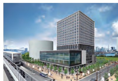
ホテル、病院、店舗、スポーツ施設等の複合ビル (東京都江東区豊洲)
