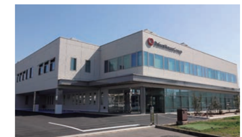
大和ハウス 佐賀ビル
