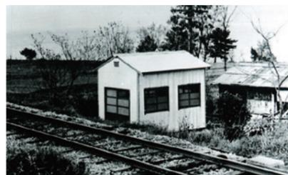
大型台風で多くの木造建物が甚大な被害に遭う中、強風に耐える竹や稲のしなやかな強さに着想し、鋼管(パイプ)構造による建築を考案。「建築の工業化」の先鞭をつけた「パイプハウス」は日本の建築に革命をもたらしました。
